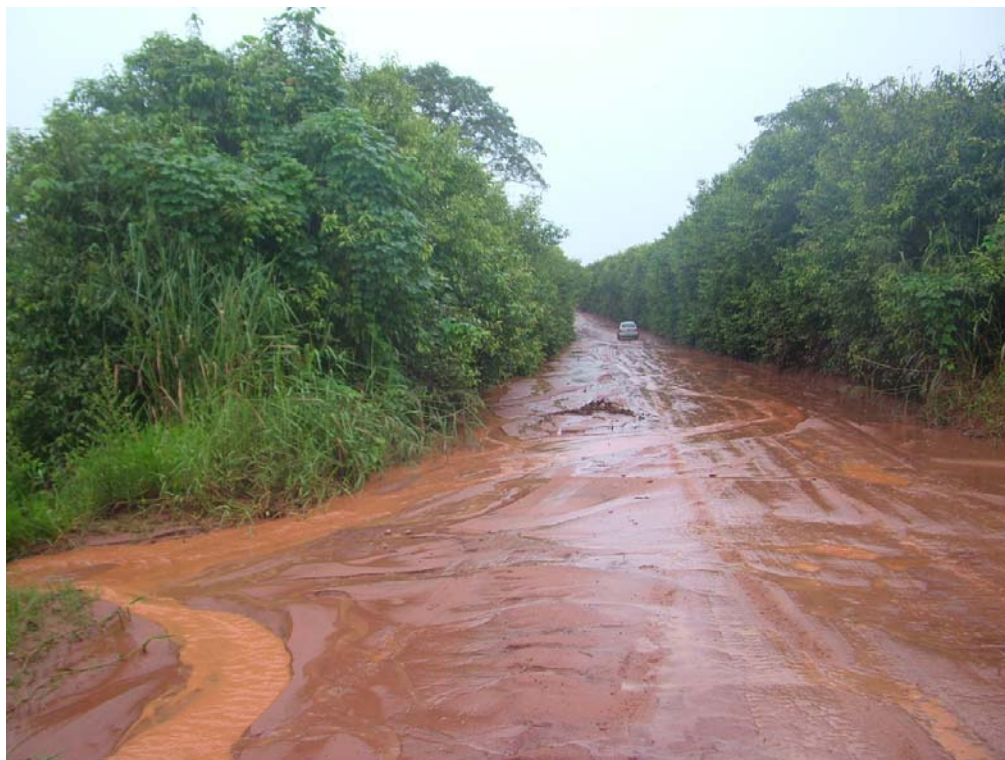
Figura 20 - Estrada municipal – servidão cortando trecho de APP da propriedade. Neste ponto observa-se carreamento de sedimentos causando assoreamento de uma drenagem da propriedade.
